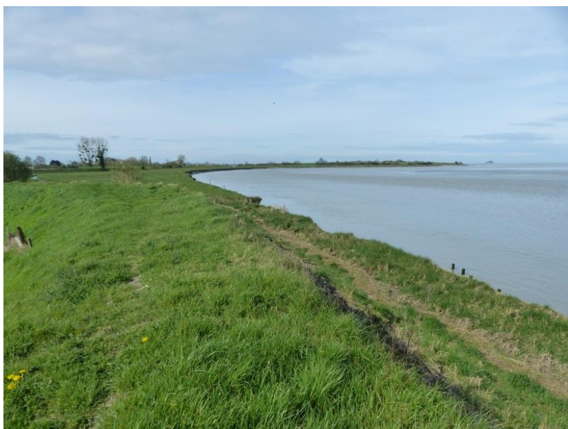
Le cheminement sur la digue offre une vue plongeante sur la baie
