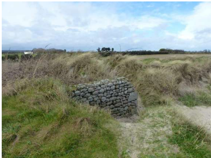
Tronçon KL : Débroussaillage du roncier pour créer le sentier derrière le mur et éviter l'érosion de la dune par le passage de promeneurs entre les parcelles 235 et 238
