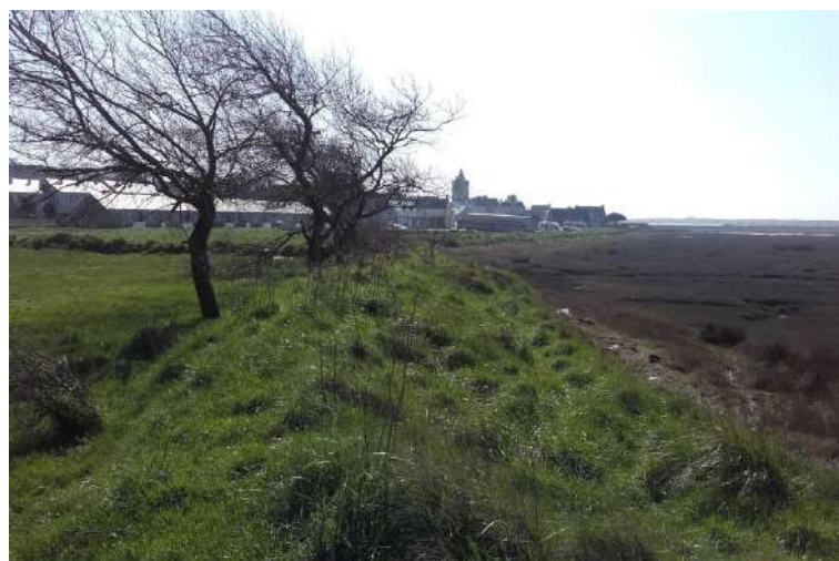
Tronçon BC : digue sur laquelle passage peut se faire facilement
