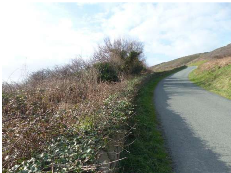
Tronçon AB : création d'un sentier derrière le mur dans les parcelles embroussaillées
