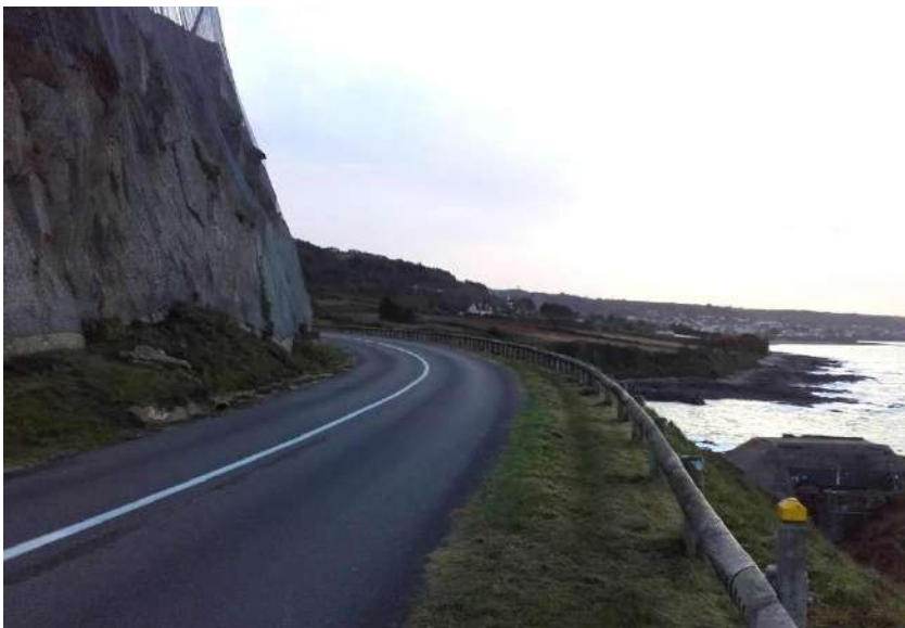
Passage dangereux et étroit dans le virage au pied des falaises
