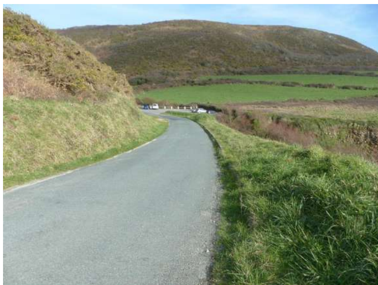
Tronçon BC : régalaie de la terre sur le trottoir
