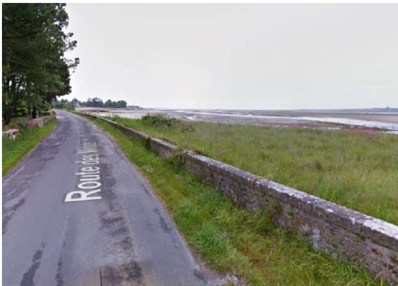
Tronçon AB : cheminement derrière le mur
