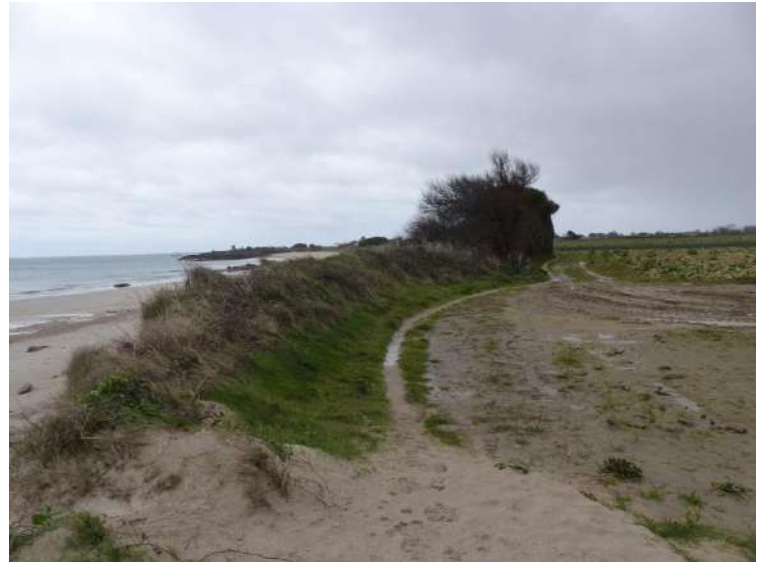
Plus loin, le sentier s'est spontanément dévié dans des parcelles privées cultivées
