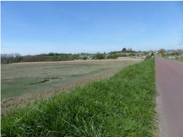
Tronçon DE : accotement RD 72
