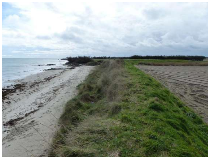
Tronçon KL : Passage sur la digue de la parcelle agricole 235
